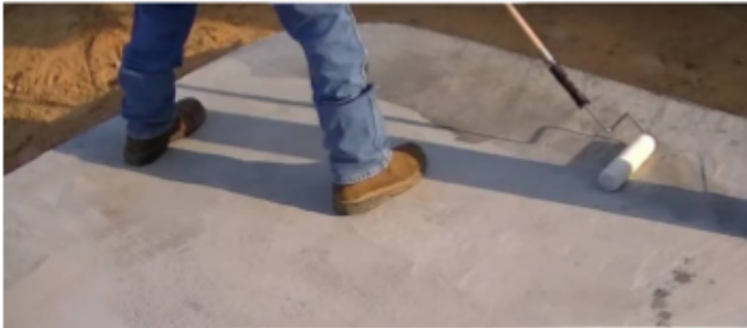
Układanie IMPRIDUR na podłoża z izolacją przeciwwilgociową.
